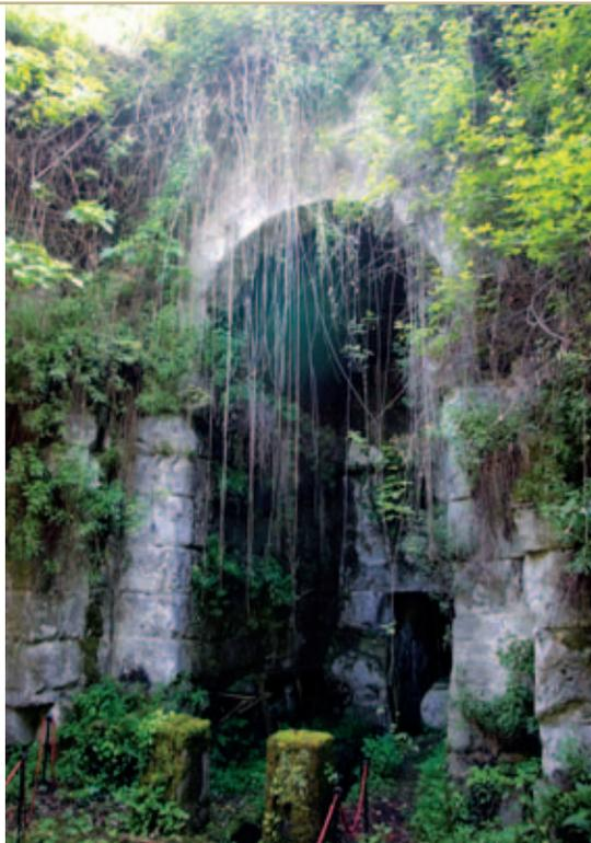
**In alto: l'imbocco dell'emissario Albano, la condotta sotterranea realizzata per tenere sotto controllo il livello del lago omonimo.**
